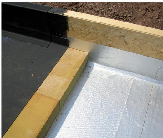
**ALUTRIX<sup>®</sup>600** est un pare-vapeur autocollant. Grâce à la feuille d'aluminium, **ALUTRIX<sup>®</sup>600** est parfaitement étanche à la vapeur et convient dès lors pour tous les types de bâtiments, même pour les piscines.
